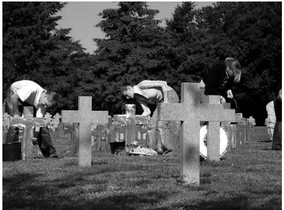
Jugendliche aus Deutschland bei Reparaturarbeiten auf einem Soldatenfriedhof in Holland. Foto:oh
