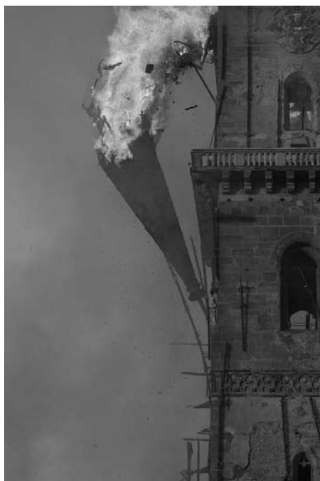
Das brennende Turmdach stürzt ab. Foto: Ioan Arcalean
